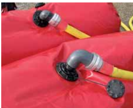
Llenado de dos tubos de agua - Filling of the tubes with water
