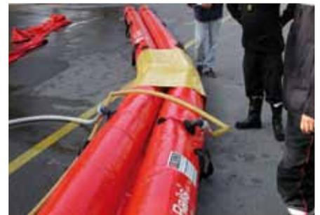
Jonction entre deux longueurs et remplissage des 2 tubes
