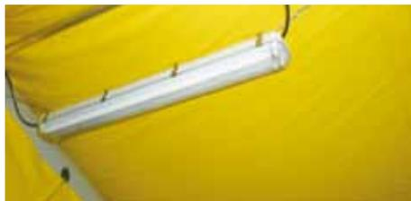
L'éclairage se présente sous la forme de doubles néons de 2 x 36W, adapté pour équiper un module de 15m<sup>2</sup>. Plusieurs blocs peuvent être branchés en série pour les tentes de grandes superficies (30 à 75m<sup>2</sup>). Le bloc est fixé sur le haut des arcs gonflables par une chaînette équipée de crochets S. Les blocs sont branchés sur un coffret de raccordement électrique en thermoplastique (indice de protection LP44LK05) comprenant :
