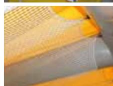
Couvrant l'espace entre deux boudins, soit la surface comprise entre les deux arêtes sablières en passant par le faitage. Les mailles ajourées permettent l'accrochage d'équipements légers (ex : coffret de raccordement électriques, etc.).
